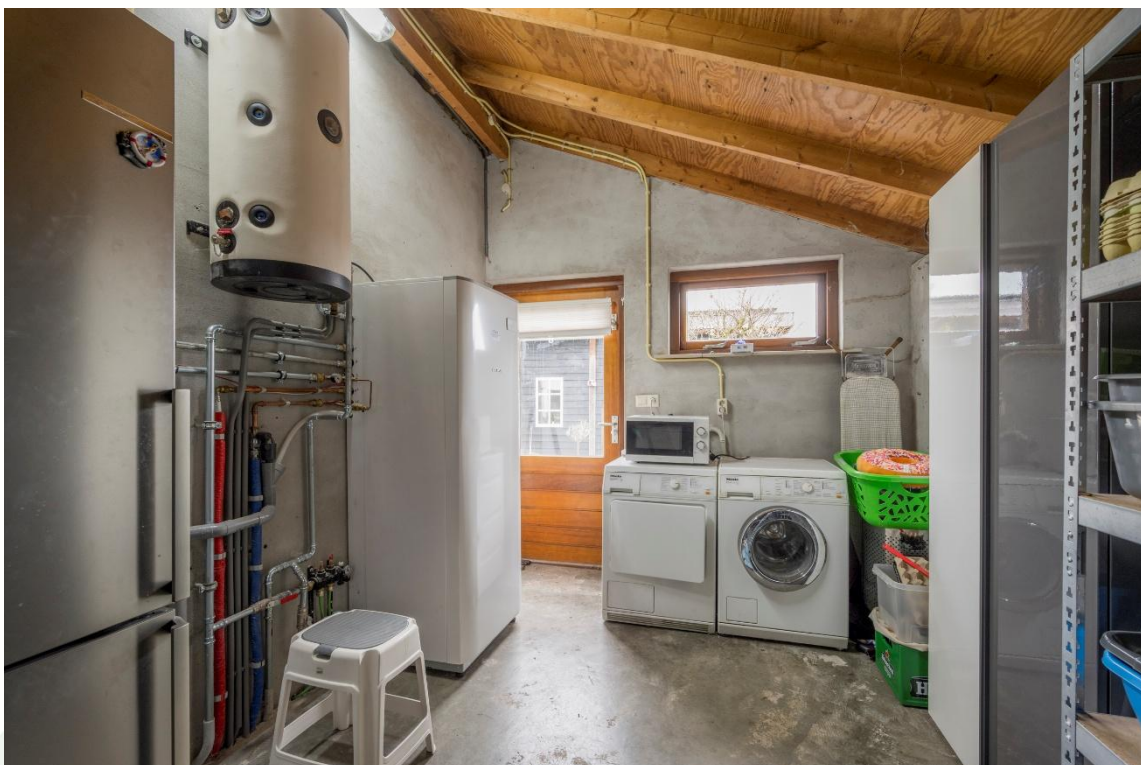
Inpandige garage; hier is het eventueel mogelijk een slaapkamer te realiseren.
